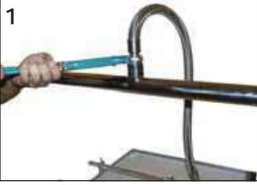
Sprinkler hortumun 1" nipel kısmı yangın hattındaki T veya manşona bağlanır.
